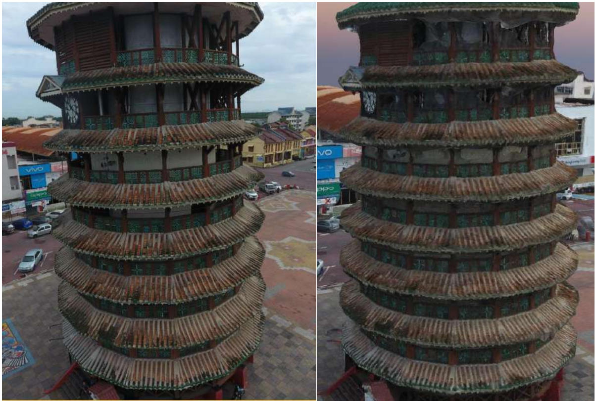
Rajah 14 : Perbandingan Imej kamera (kiri) dengan 3D Textured mesh(Kanan) .
