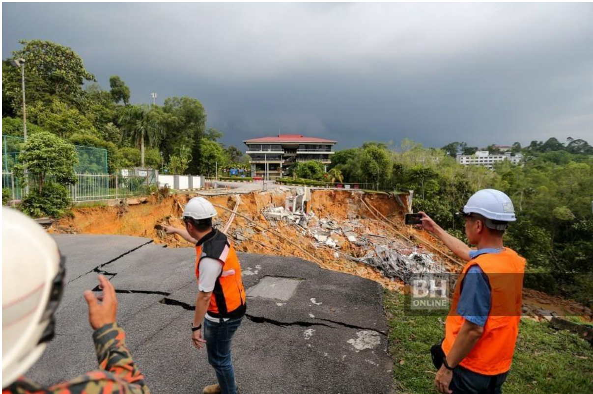
Keadaan kejadian tanah runtuh di bangunan Akademi Pencegahan Rasuah Malaysia (MACA), Kuala Lumpur, semalam. - NSTP/Aswadi Alias
