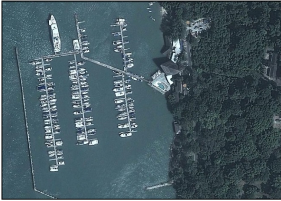
Rajah 4: Pembangunan kemudahan bagi aktiviti pelayaran di Langkawi, Kedah (sumber: Google Earth)
